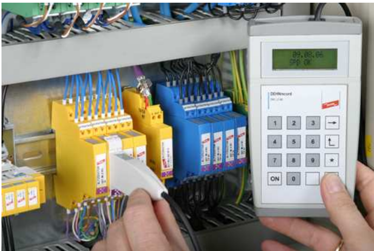
Rys. 7. Sprawdzanie właściwości SPD stosowanych w obwodach sygnałowych
