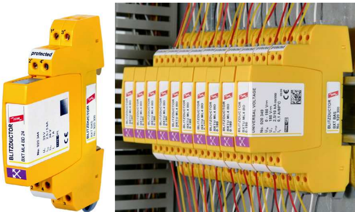
Rys. 6. Przykład montażu SPD na szynie 35 mm
