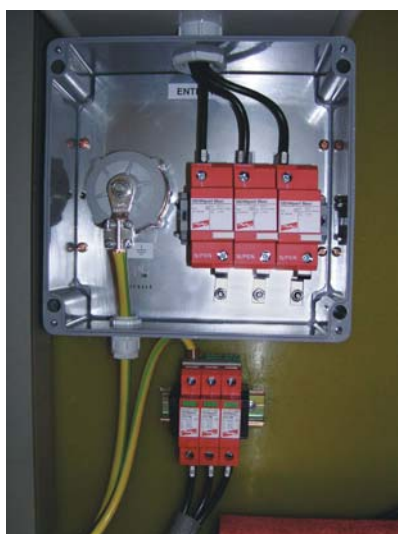
Rys.3 Ochrona przed przebieciami sterownika zainstalowanego w sąsiedztwie rozdzielnic głównej obiektu
