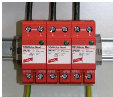
Rys.2. Układ połączeń ograniczników przepięć w instalacji elektrycznej zasilającej sterownik przemysłowy ; a) dwustopniowy system ograniczników, b) trójstopniowy system ograniczników,
