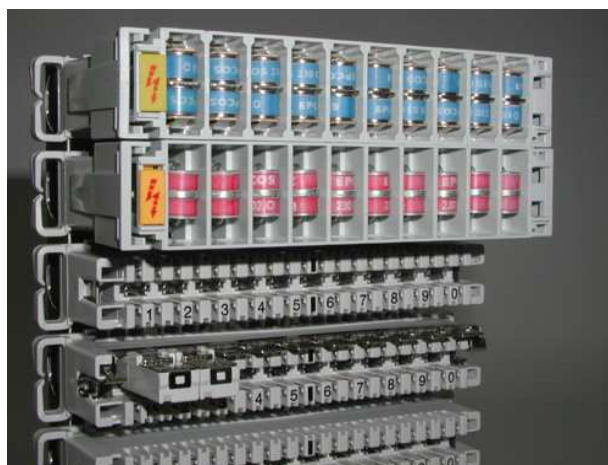
Rys. 14. Przykładowe urządzenia do ograniczania przepięć w obwodach telefonicznych
